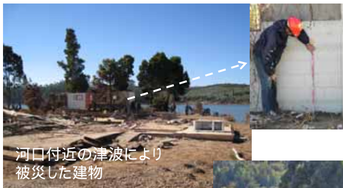
建物の壁に残った後から、破線の位置まで津波が到達したと推定される(4m以上)
