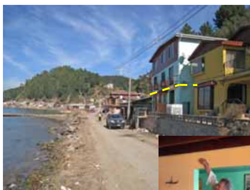
3階建て建物(緑)の1階天井まで津波が到達したそうだが、建物内外の壁にひび割れ等は見られなかった(RC枠組み組積造)
