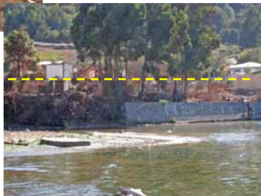
建物の壁に残った後から、破線の位置まで津波が到達したと推定される(4m以上)
