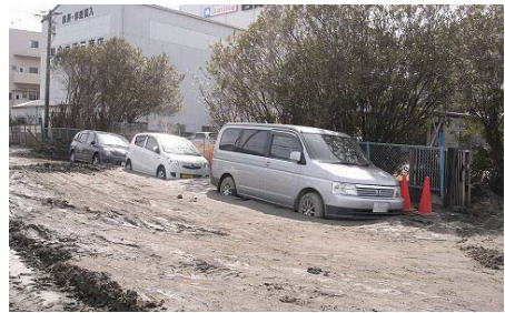
千葉市美浜区の液状化被害
