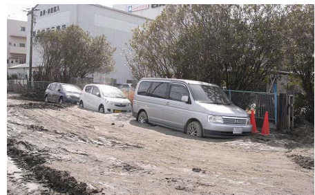
千葉市美浜区の液状化被害
